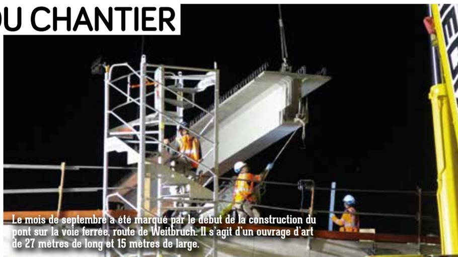
Le mois de septembre a été marqué par le début de la construction du pont sur la voie ferrée, route de Weitbruch. Il s'agit d'un ouvrage d'art de 27 mètres de long et 15 mètres de large.
