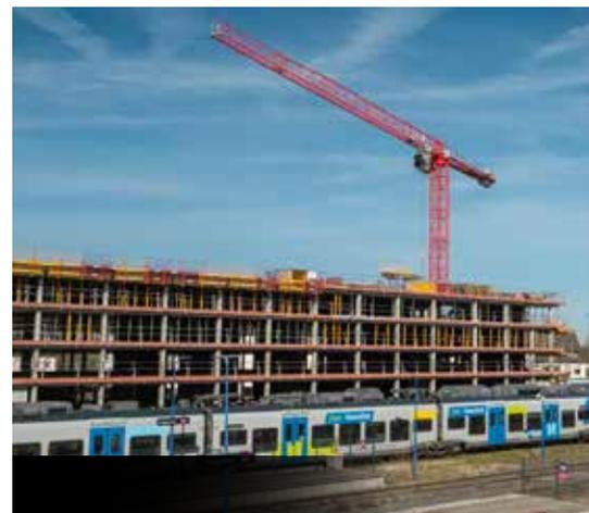
Les travaux du parking silo de la gare de Haguenau avancent conformément au calendrier prévisionnel. Les travaux de gros œuvre se finissent, la pose de la charpente métallique et des panneaux photovoltaïques est programmée pour cet été. Le nouvel équipement offrira 600 places de stationnement sur cinq niveaux ainsi que 300 places pour les vélos.
