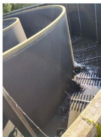
Opération de vidange et de nettoyage des bassins d'épuration à la station de Bischwiller (file A), avec remplacement des diffuseurs d'air.
