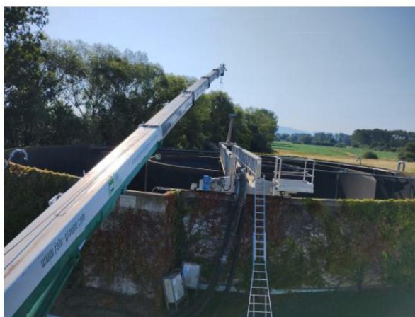
Opération de vidange et de nettoyage des bassins d'épuration à la station de Bischwiller (file A), avec remplacement des diffuseurs d'air.
