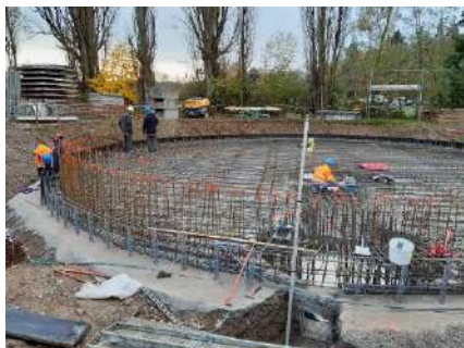
Construction du bassin de dépollution de 500 m3 à Schweighouse s/M
