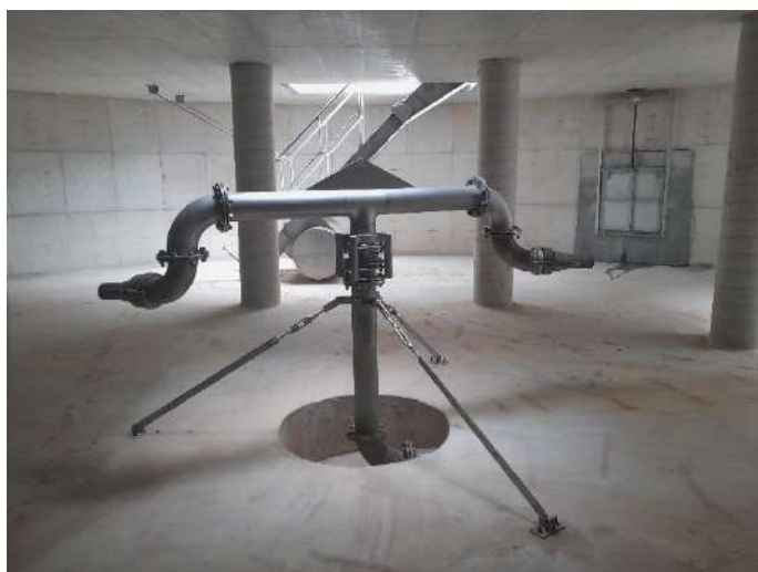
Bassin – Système de nettoyage automatique
