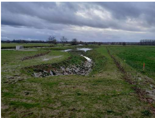
Zone de rejet végétalisé
