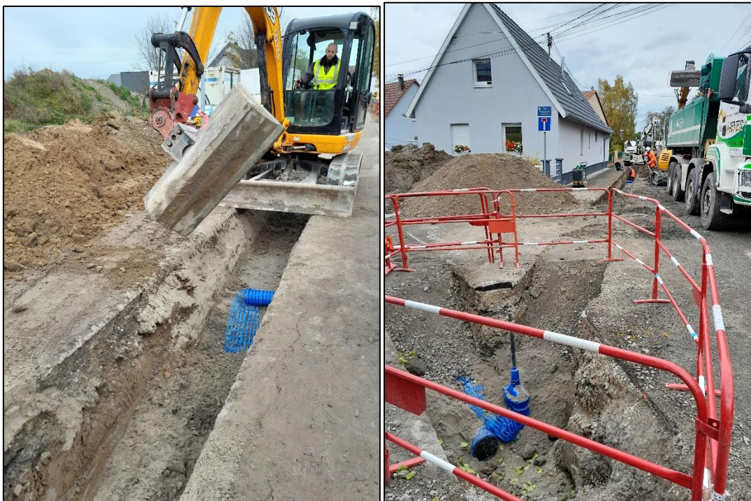
Pose de la nouvelle conduite principale dans la Rue de Limoges
