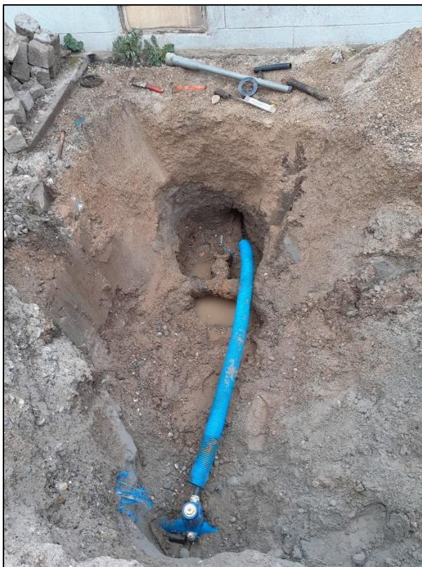
Rénovation des branchements particuliers
