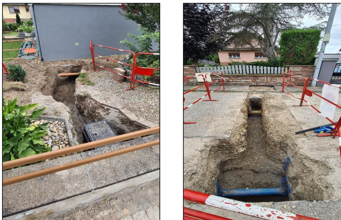
Rénovation des branchements d'eau potable et mise en place d'un regard de comptage
