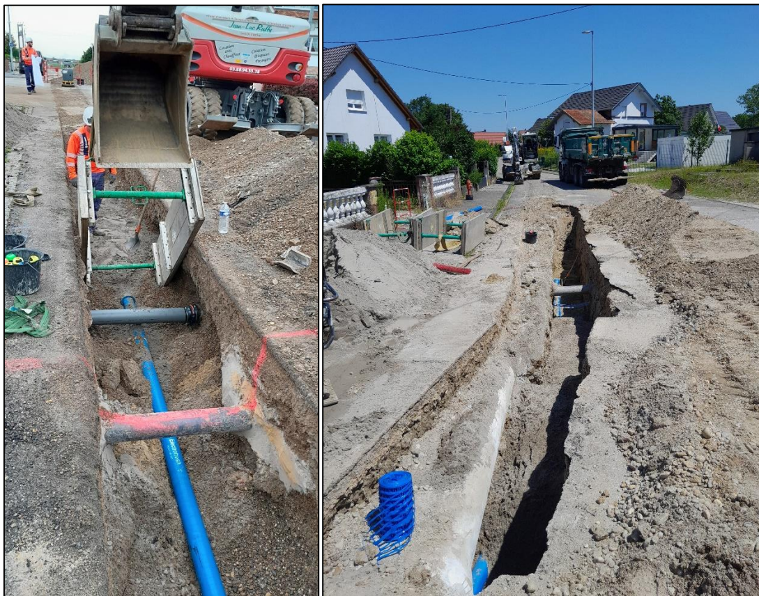
Pose de la nouvelle conduite principale dans la Rue de l'Alliance
