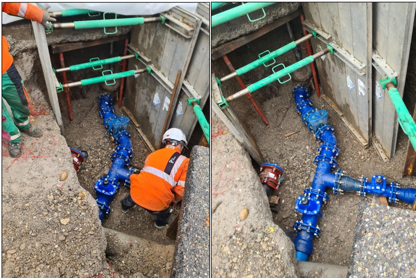
Raccordement de la nouvelle conduite d'eau potable au croisement de la Rue du Stade et de la Rue de La Paix
