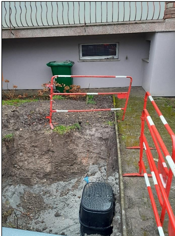
Rénovation des branchements particuliers
