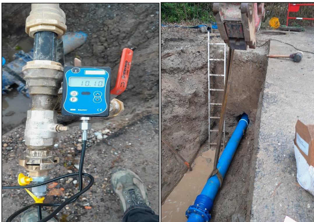
Réalisation de l'essai pression
