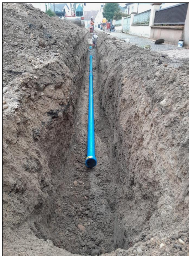
Pose de la nouvelle conduite principale d’eau potable dans la rue de Schirrhein à Drusenheim
