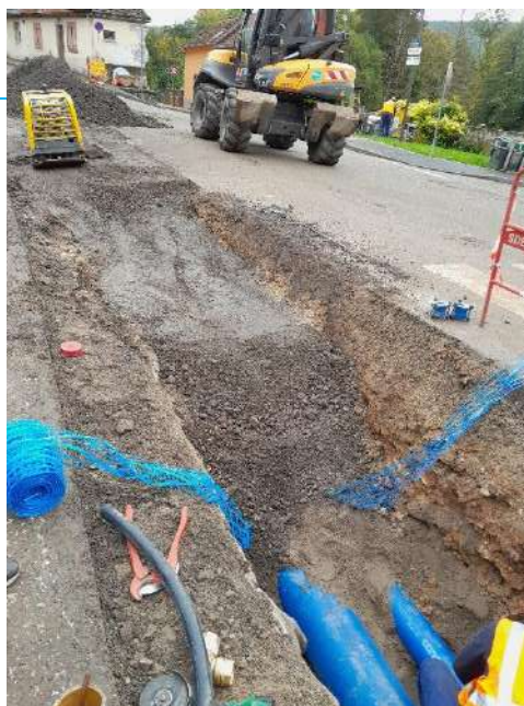
Remplacement des canalisations Ø 300 & Ø 150
