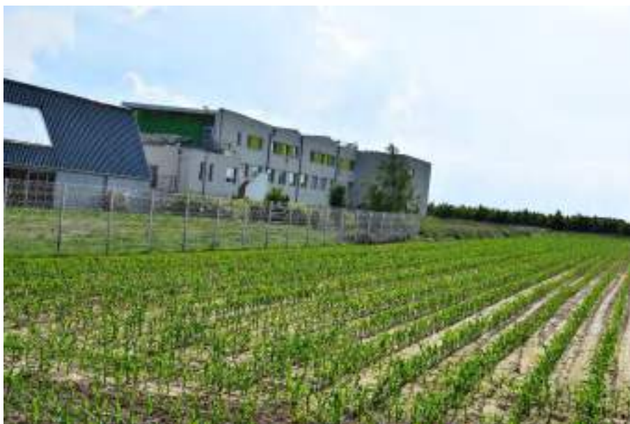
La façade arrière de l'école
