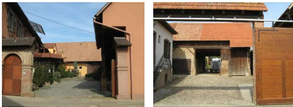
Illustration 33 : Vue sur quelques corps de ferme (Rue principale)
