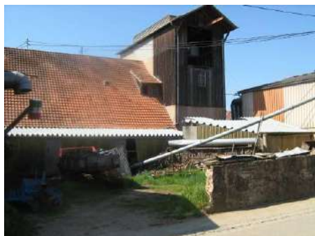
Corps de ferme situé Rue des Champs
