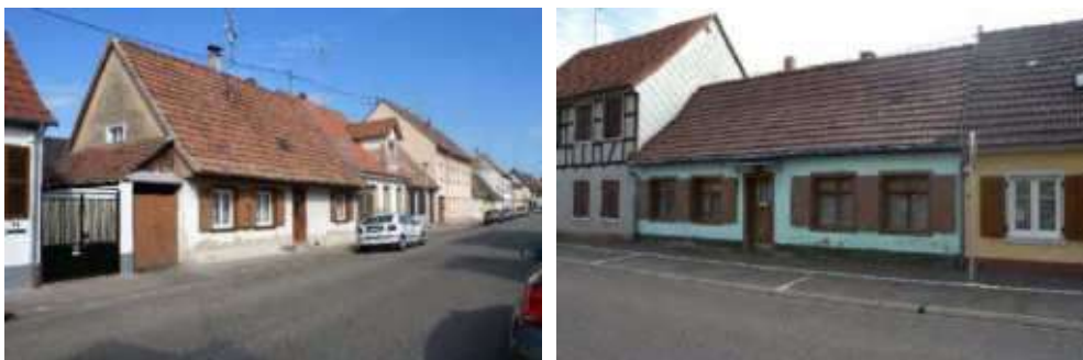
Maisons ouvrières fidèles au modèle d'origine : rue de la République (à gauche) et rue du Houblon (à droite).
