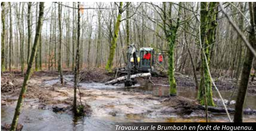
Travaux sur le Brumbach en forêt de Haguenau.
